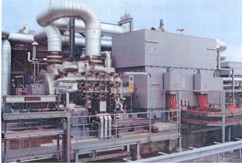
Bild 3.2.8-10: Explosionsgeschützter magnetgelagerter 2-poliger Synchronmotor in Überdruckkapselung und gekuppelter Gaskompressor (links), Erdgasfeld Groningen/Holland, Projekt NAM (Quelle: Siemens AG)
