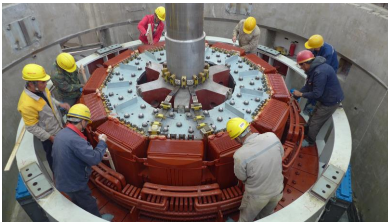
Bild T1.4-2: Einbau des 12-poligen Rotors mit Vierfach-Hammerkopf-Befestigung der Läuferpole in eine Vertikal-Schenkelpolmaschine: 24 MW, Wasserkraftwerk Sanchahe , VR China , (Quelle: Andritz Hydro AG ).
