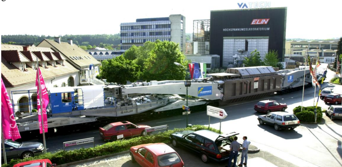
Bild T3.4-5: Transport eines großen Dreiphasen-Transformators mit dem Schnabelwagen auf der Bahn. Der Schnabelwagen kann ca. 20 Tonnen je Achse als Last tragen. Bei 32 Achsen sind das ca. 640 Tonnen max. Transformatormasse, die ohne Ölfüllung und Hochspannungsdurchführungen transportiert wird (Quelle: ELIN Transformatoren GmbH, Weiz, Österreich, jetzt: Siemens AG ).
