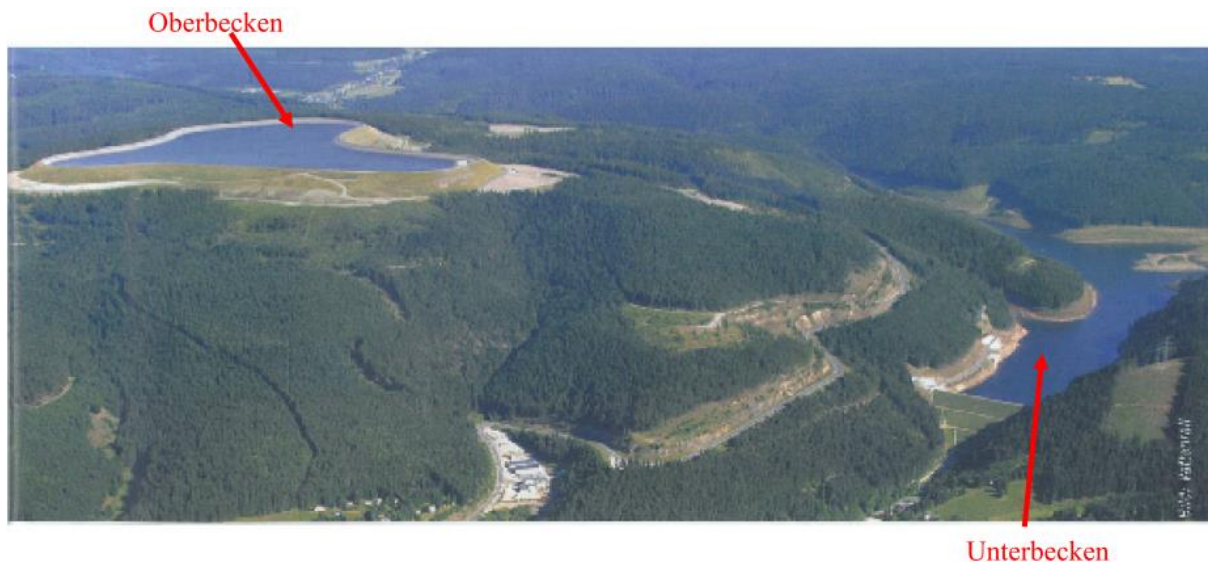
Bild P3.2.5-8: Kavernen-Pumpspeicher-Kraftwerk Goldisthal/Thüringen, D, 1060 MW mit vier Francis-Pumpturbinen. Zwei der vier Turbinen-Generator-Einheiten sind drehzahlveränderbar (Quelle: BWK 67, 2015, no. 1/2).
