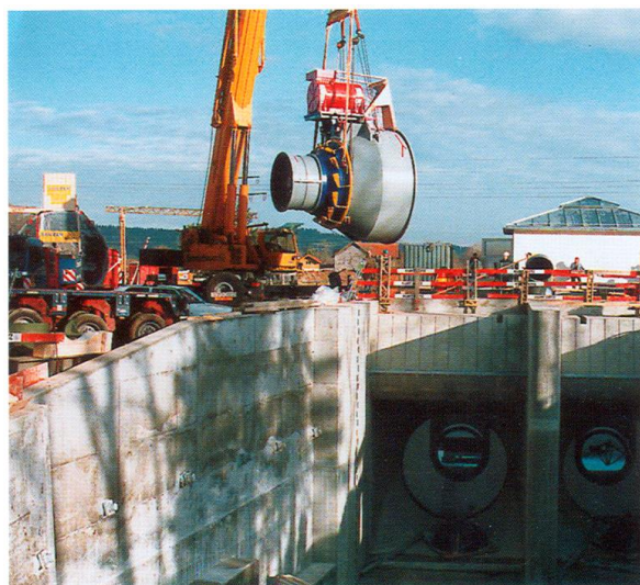
Bild P3.2.3-10: Links: Einbau des Leitapparats einer Kaplan -Turbine in Rohrturbinenbauweise in einem Flusswasserkraftwerk, b) Rechts: Sonderbauform der Propellerturbine als Straight-Flow-Turbine, an deren Außenkranz um die Schaufeln der Rotor des Synchrongenerators direkt befestigt ist (Quelle: Andritz Hydro , A).
