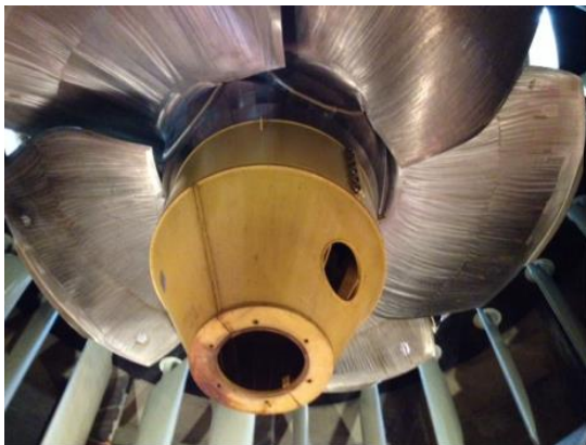
Laufwasserkraftwerk Ybbs-Persenbeug , A, Donau -Fluss
