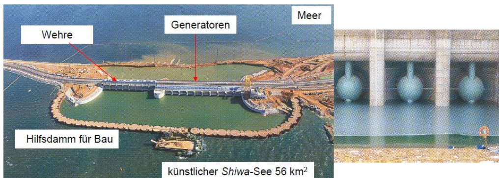
Bild R5.1-3: Siwha-ho Gezeitenkraftwerk, S-Korea, 10 x 25.4 MVA (Fotos aus Bauphase 2011), rechts Frontansicht (Binnensee-Seite) von drei Rohrturbinen-Generatoreinheiten (Quelle: Andritz Hydro, Österreich).
