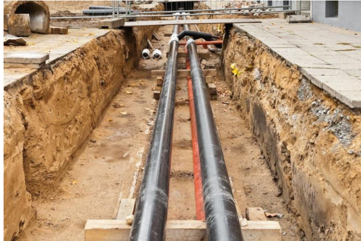
Bild R13.1-2 : Verlegung von Fernwärmerohren (Vor- und Rücklauf) in der Baugrube (Quelle: BWK 69 (2017) no. 10 & Mainova, Frankfurt ).
