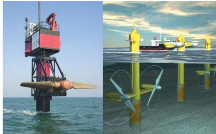
Bild R5.2-2: Links: Gezeitenstrom-Kraftwerk (Prototypanlage) Projekt „Seaflow“ vor der britischen Westküste zur Nutzung des Gezeitenstroms für die el. Energieerzeugung, rechts: Geplante künftige Kraftwerksausführung mit Wartungsarbeiten am mittleren Turm (Quelle: V. Quaschnig, Regenerative Energiesysteme).
