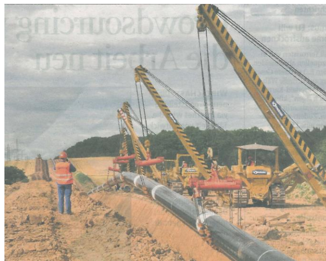
Bild R7.4-5: Pipelinebau der Midal-Süd Loop 2013 als 90 km-Strecke zwischen Reckrod bei Fulda und Wirtheim bei Gelnhausen (Quelle: Gascade, aus VDI-nachrichten, 07/2016).
