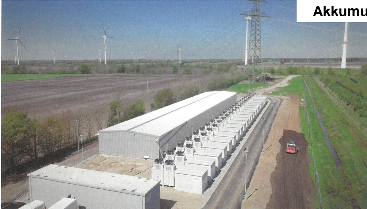
Außenansicht: Batteriespeicher Jardelund, Schleswig-Holstein
