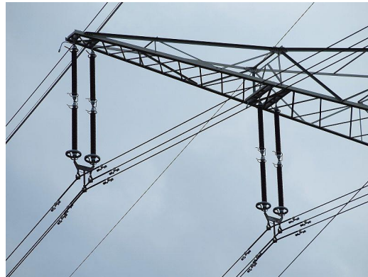
Dreifach-Bündelleiter 220 kV-Leitung
