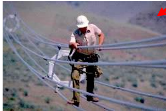
Achtfach-Bündelleiter 1000 kV-Leitung
