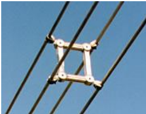
Vierfach-Bündelleiter 380 kV-Leitung
