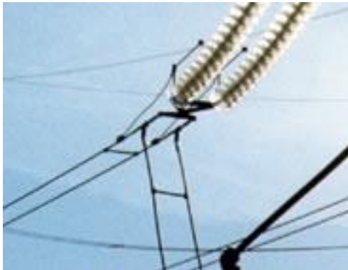
Zweifach-Bündelleiter 110 kV-Leitung
