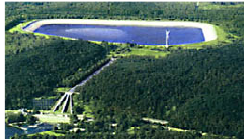
Pumpspeicherwerk Geesthacht bei Hamburg
