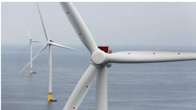
Abbildung 1: Offshore-Turbine mit Direktantrieb (154 m Rotordurchmesser mit 6 MW Leistung) [Quelle: Siemens AG]
